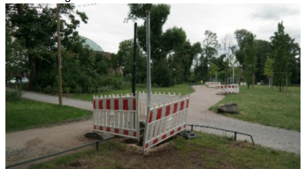
Reparatur der Gasbeleuchtung im Hofgarten
