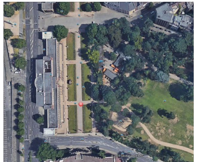
Luftbild Ehrenhof und Hofgartenrand mit Betriebshof
